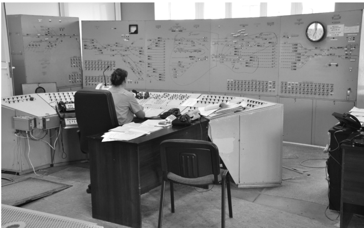
Рис. 8. Рабочее место дежурного по станции
